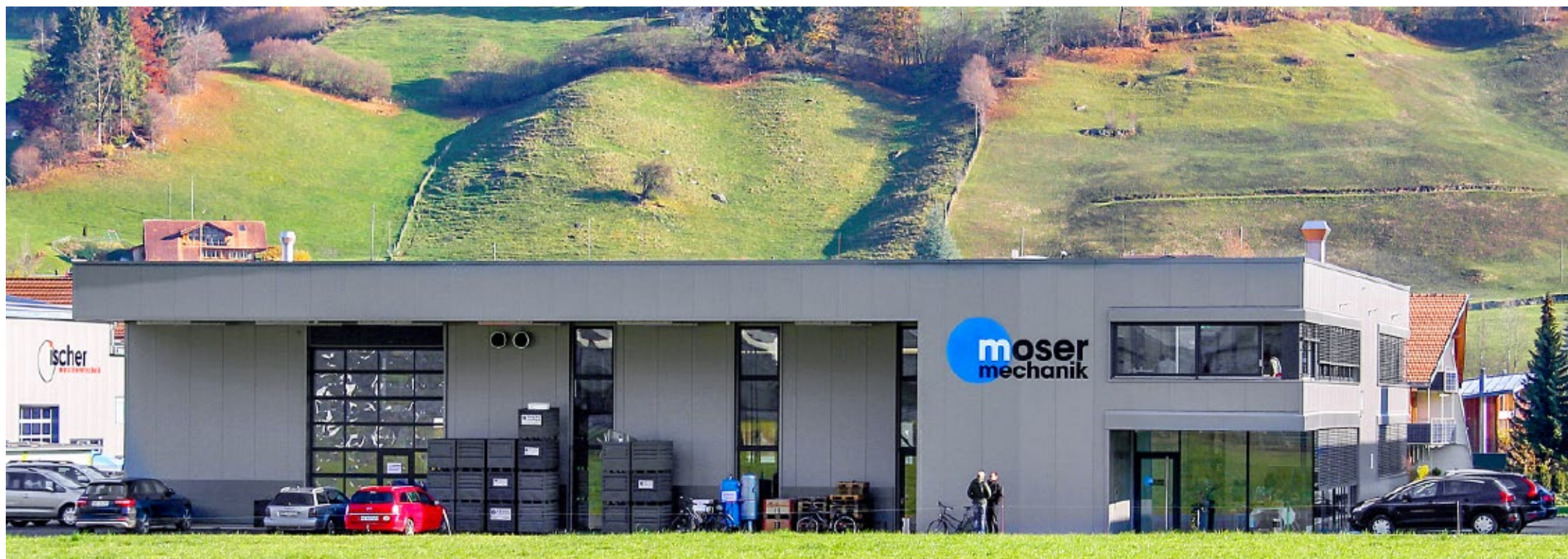
In ihrem neuen Gebäude an der Christoph Kunz Olympiastrasse hat die Moser Mechanik AG 2000 Quadratmeter zur Verfügung. Bei Bedarf liesse sich die Fläche sogar noch erweitern.
